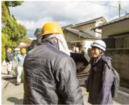
道路舗装作業を監督する山本さん
