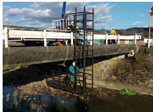
図 2. 新たな組み立て式橋梁点検足場の開発
