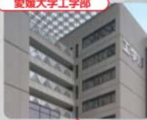
愛媛大学工学部
