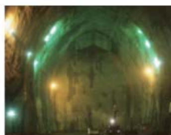
岩盤中におけるLPG備蓄用空洞の施工 (国家石油ガス備蓄基地 高さ30m×幅26m)
