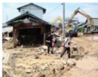
集中豪雨による災害調査 (2004年 愛媛県新居浜市)
